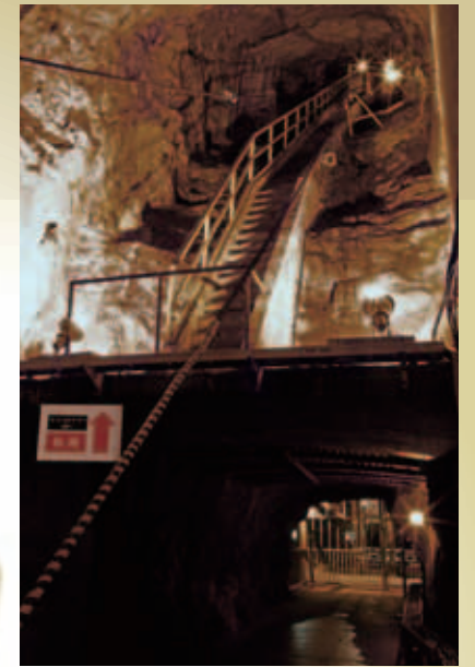
光榮垂直坑道升降機(電梯)
